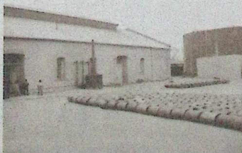
Patio con materiales.
